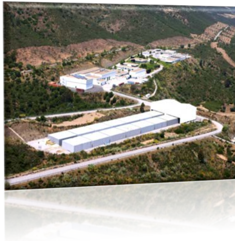
El Cabril, almacén de residuos radiactivos de muy baja, baja y media actividad
