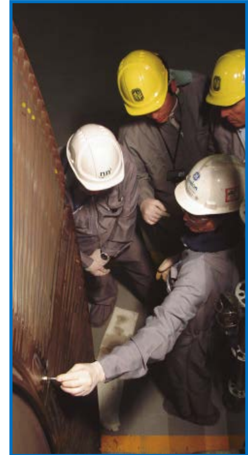
Trabajos comprobación turbina
