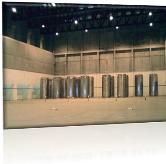
Almacén Temporal Individualizado de la central nuclear de Trillo para su combustible nuclear gastado
