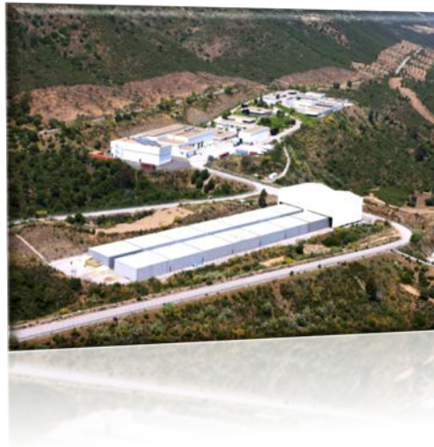
El Cabril, almacén de residuos radiactivos de muy baja, baja y media actividad
