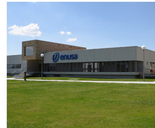
Fábrica de elementos combustibles de Juzbado, Salamanca
